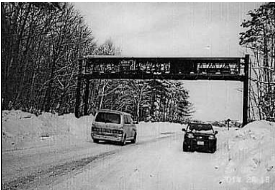
Boombrug voor Japanse relmuis(constructie 3) (foto Minato)
