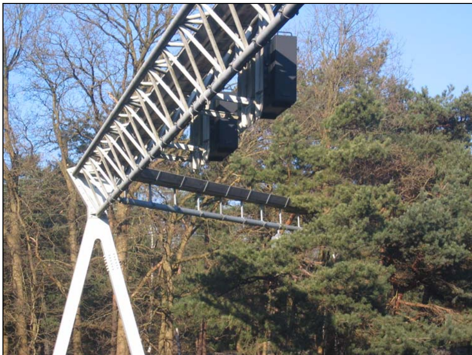
Boommarterbrug over de A12 in het gebied ‘Gelderse Vallei’ nabij Driebergen in Nederland (constructie 2). (foto Econnection)
