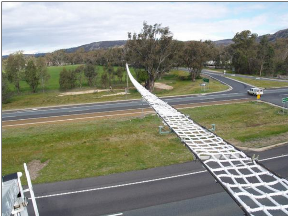
Voorbeeld van een touwladder met net (constructie 42)
