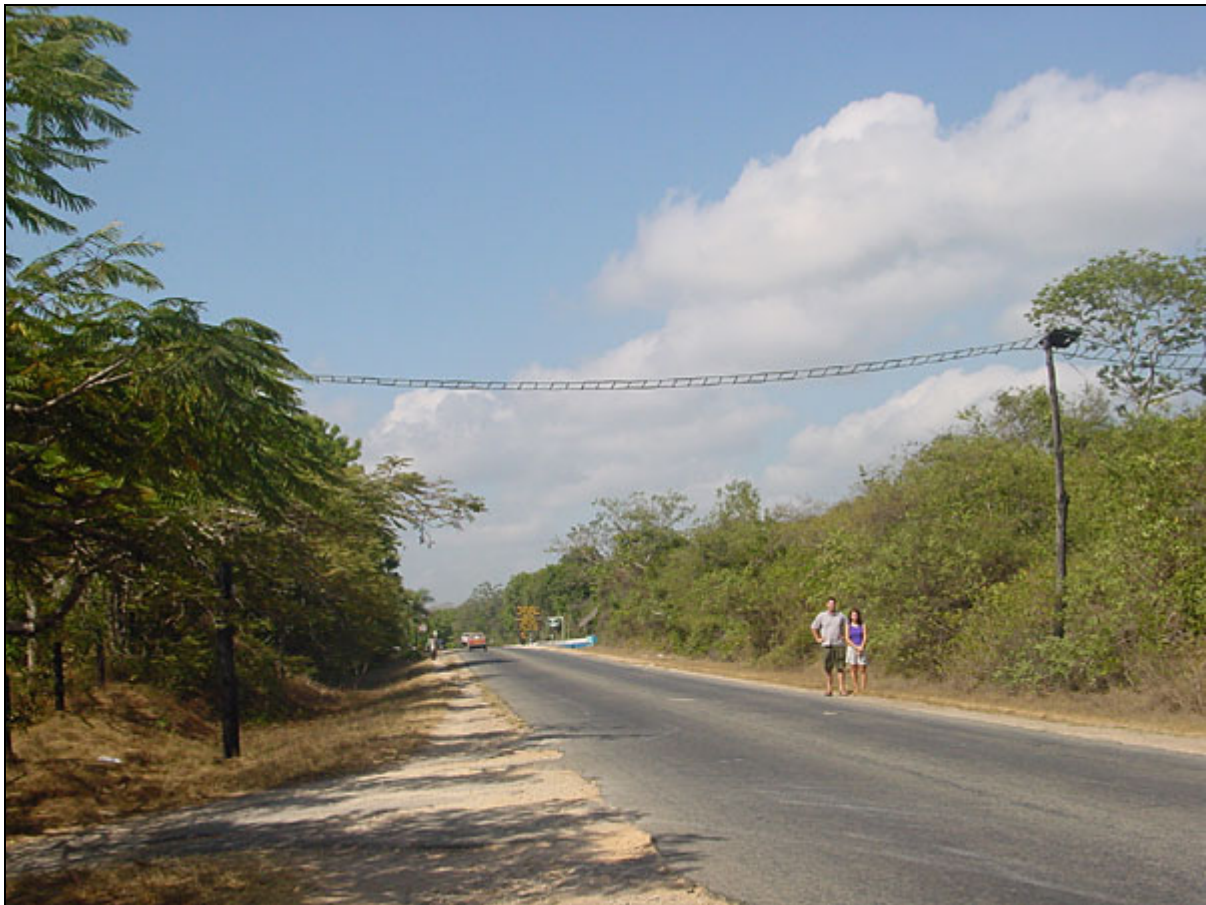
Hoogte en lengte worden bepaald door de verkeerssituatie en de afstand tot dichtstbijzijnde opgaande begroeiing. De brug (constructie 17) mag het verkeer niet hinderen en de bomenrand bevindt zich zo dicht mogelijk bij de straatrand. (foto Colobus Trust)
