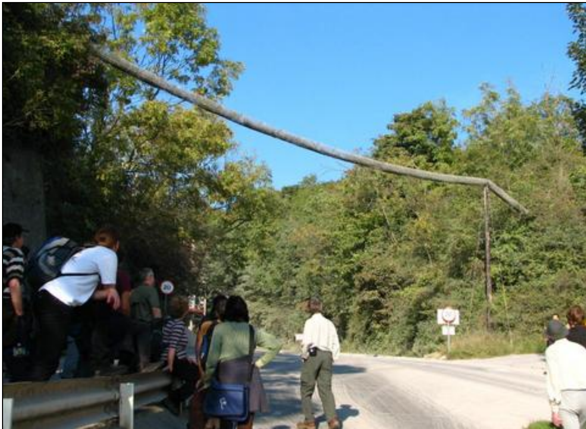
Voorbeeld van een kokerbrug (constructie 39) (foto Goedele Verbeylen)
