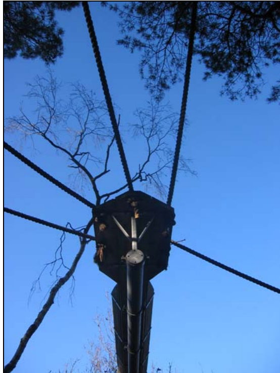
Aanzitplaats aan de toegang respectievelijk uitgang van een boomgoot aan een portaalboombrug (constructie 2). Deze staat met verschillende touwen in verbinding met de boomkronen van aangrenzende bomen. (foto Econnection)
