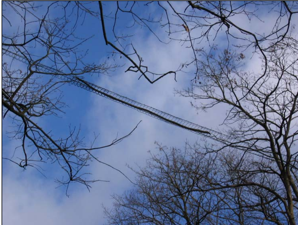
Enkelvoudige boombrug voor eekhoorn ter hoogte van het park Den Brandt in de stad Antwerpen (constructie 1). (foto Econnection)
