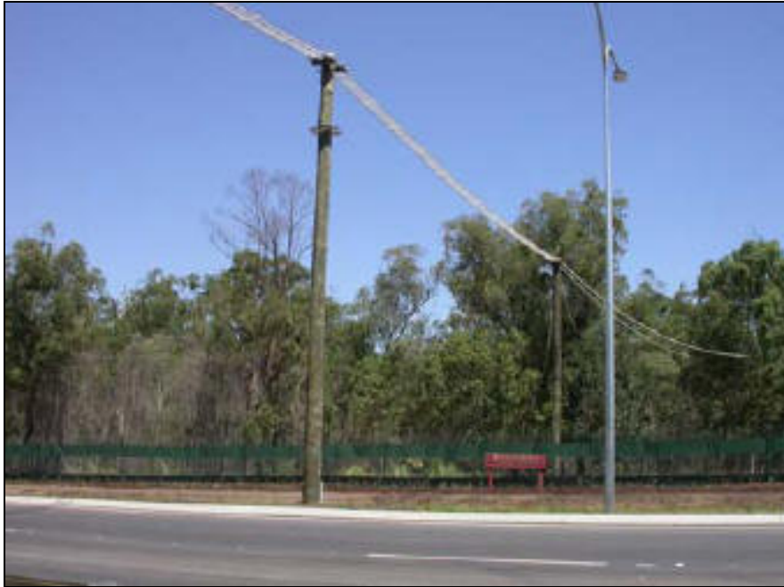
Bevestiging van een boombrug aan gefundeerde palen verhoogt de veiligheid omdat deze steviger zijn en de kans op gebreken quasi uitgesloten is. Dit in tegenstelling tot een bomen die levende materie is en onderhevig aan gebreken. (foto Pauline Fitzgibbon)
