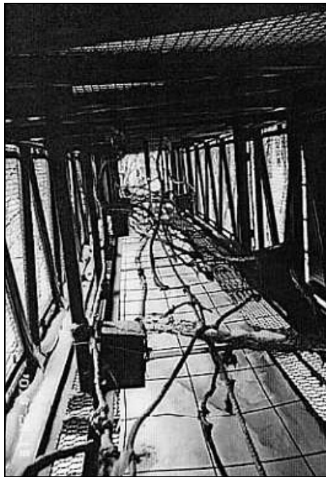
Portaalboombrug voor Japanse relmuis met nestkasten en extra klimvoorzieningen(constructie 3) (foto Minato)
