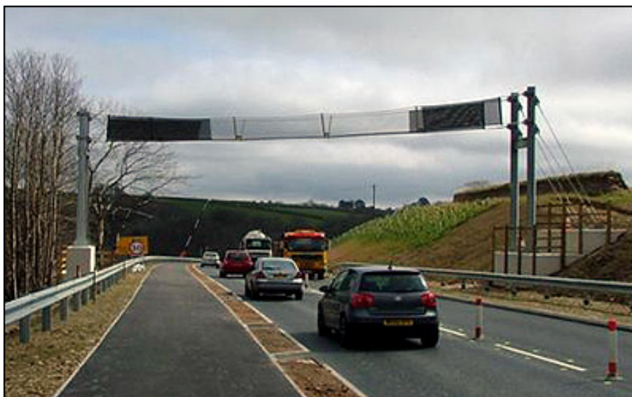
In Groot-Brittannië wordt met “hop-overs” voor vleermuizen geëxperimenteerd die veel gelijkenis vertonen met boombruggen. Boombruggen kunnen eveneens vleermuizen op een veilige hoogte over drukke wegen geleiden.
