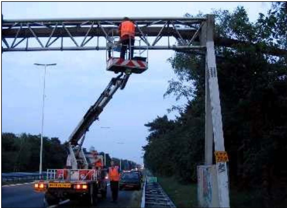
De geprefabriceerde stukken van een boombrug (constructie 2) worden doorgaans met behulp van een hoogwerker op de locatie aangebracht. (foto Van Doorn)
