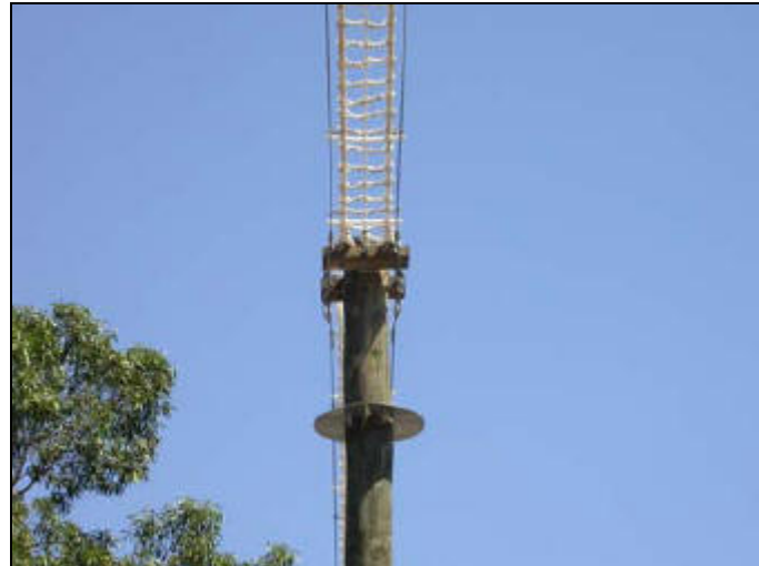
Een kraagconstructie moet dieren ervan weerhouden om de boombrug te verlaten via een ongewenste weg en dwingt hen in de richting van het uiteinde van de boombrug. (foto Pauline Fitzgibbon)
