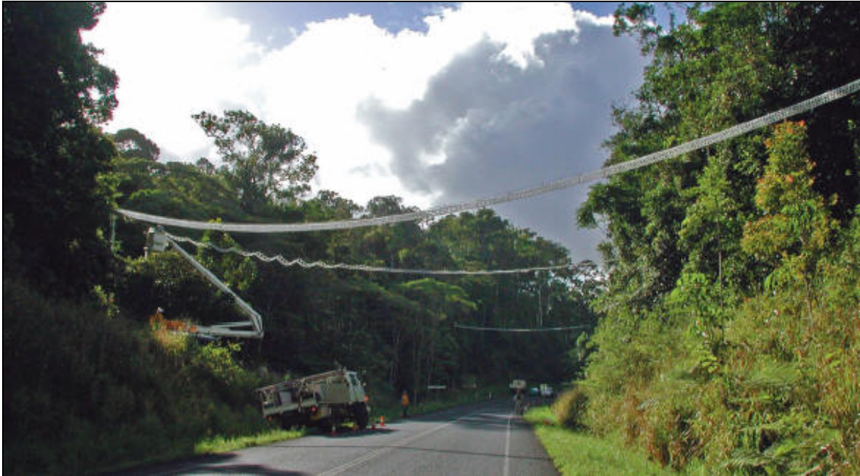
In grote aaneengesloten bossen die door een weg doorsneden worden, is het wenselijk om meerdere boombruggen (constructie 18) op regelmatige afstanden van elkaar te voorzien. (foto Birgit Kuehn)
