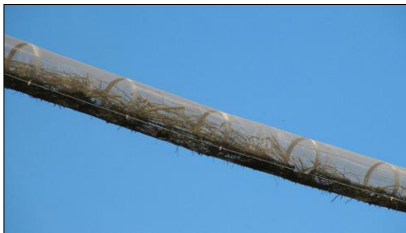
Kokerbrug (constructie 39) gevuld met ranken en takken.
