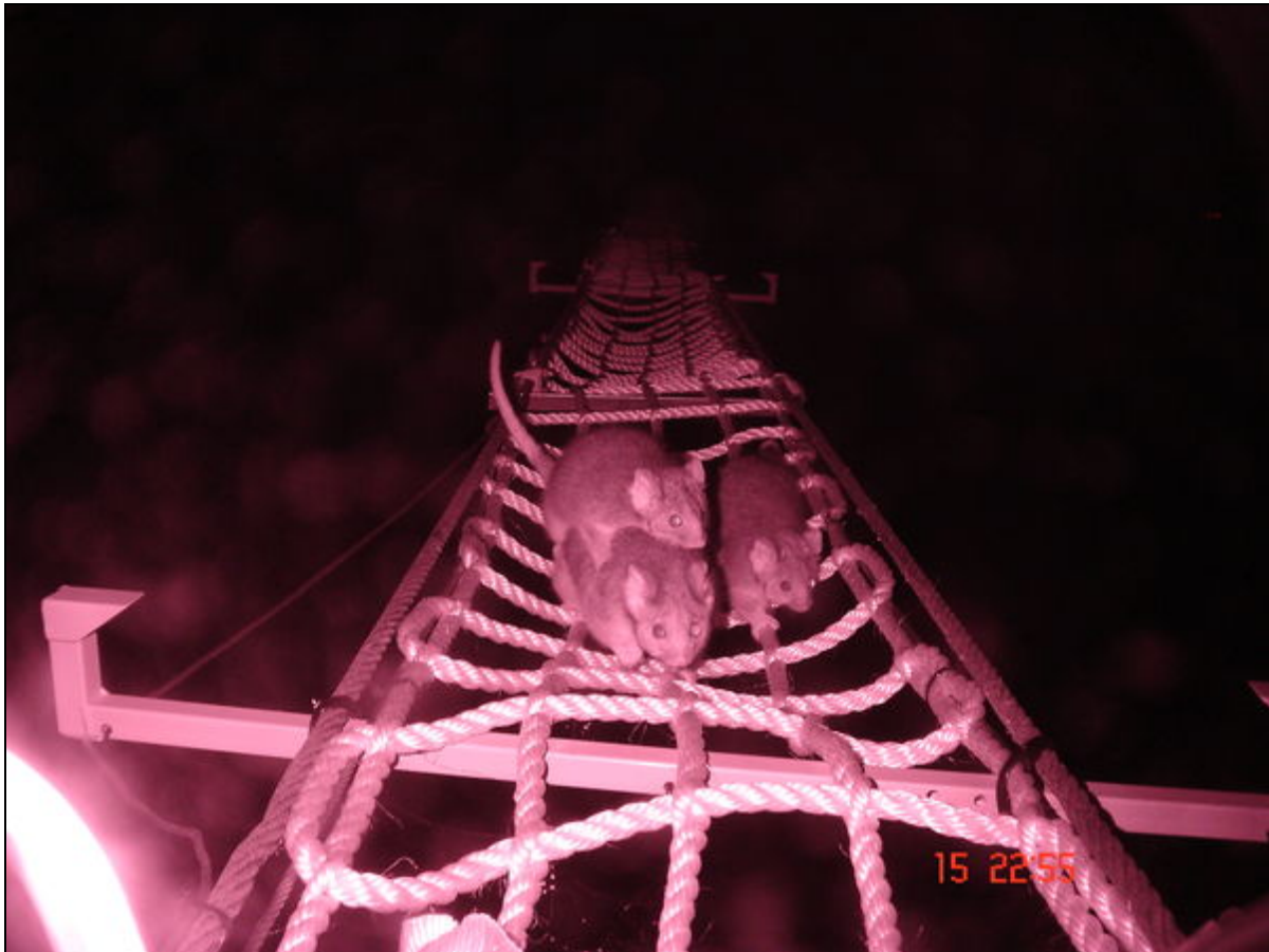
Het systeem van een touwladder (constructie 18) werd ontworpen nadat werd vastgesteld dat buideldieren die van een touwtunnel gebruik maakten hoofdzakelijk bovenop de voorziening liepen.
