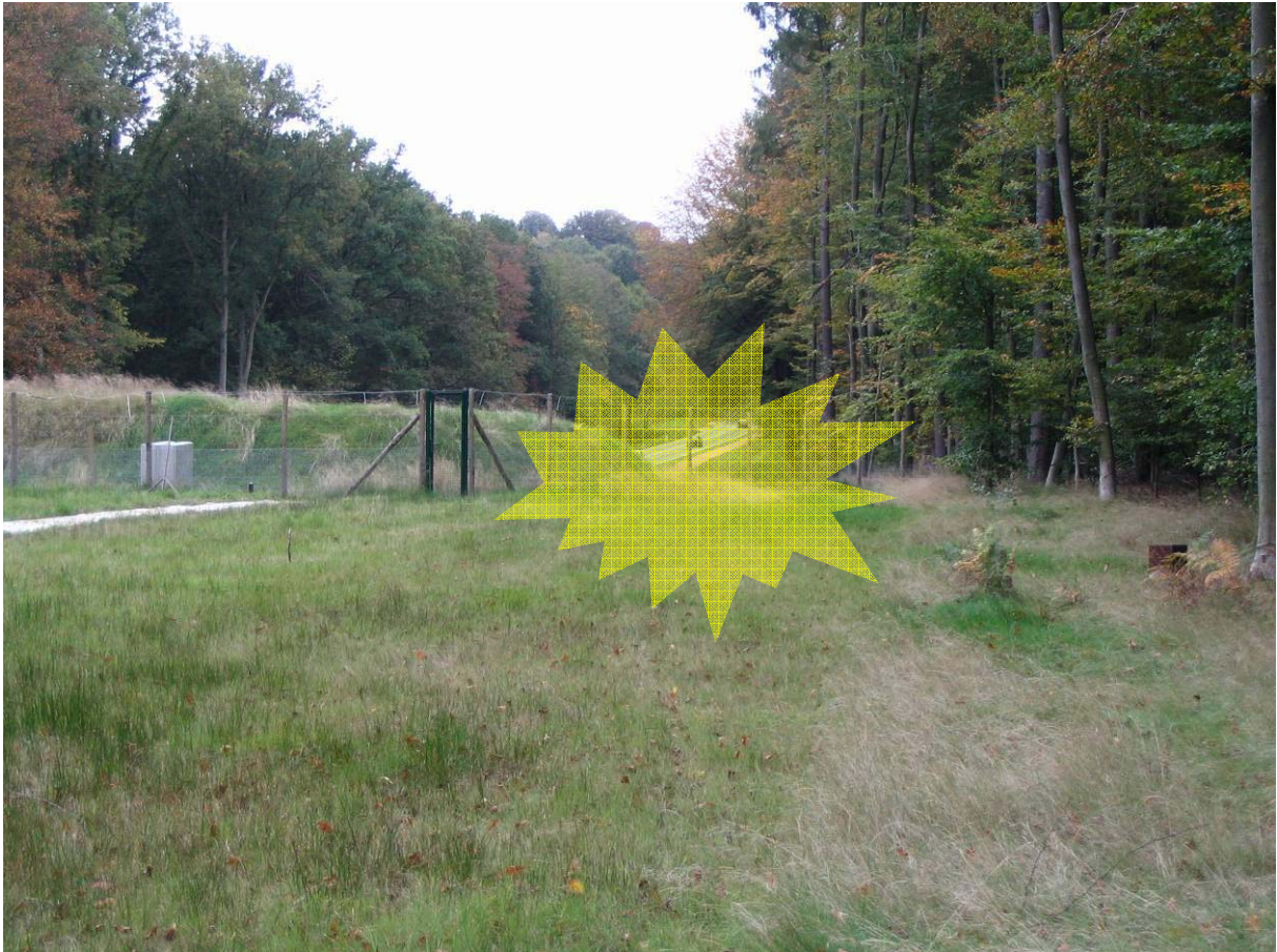
Foto 4.2.1.4: Zicht op de zuidwestelijke hoek van het ecoduct. De instraling van het licht wordt voorgesteld door de gele ster. Om dit probleem te remediëren wordt voorgesteld om het bestaande hekwerk af te schermen met een opaak scherm.
