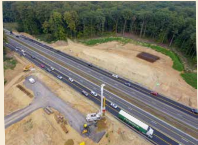
Bovenaanzicht funderingswerken, gestockeerde lokale gronden en tijdelijke rijvakken (©Life+OZON)
