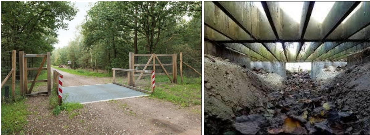
Figuur 24: Wildrooster van vlakke staven (links) (© Arfman) en detail van de zijtoegang voor herpetofauna (rechts) (© Natura).
