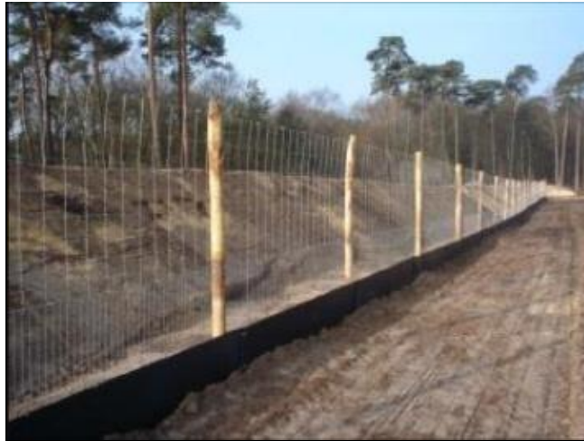
Figuur 20: Combinatieraster voor kleine en middelgrote zoogdieren en herpetofauna (© Arfman).
